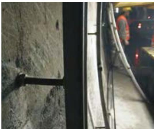
Il nostro ancorante SITA, nella sua versione in acciaio Inox AISI 316L, è stato ampiamente utilizzato nel cantiere del Monte Bianco per fissare le centine metalliche di sostegno dei pannelli di rivestimento delle pareti della galleria. Omologato resistenza al fuoco 120' secondo curva delle temperature ISO 834 presso IBMB Braunschweig.
